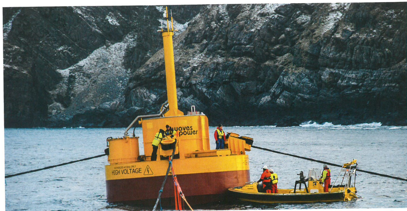
Her er installasjonen utenfor Runde. WaveEL med hub. Foto: Waves4Power.
