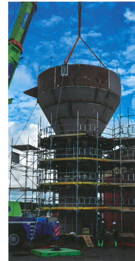
Slik ser kraftverket ut før det settes i sjøen. Foto: Wave4Power.
